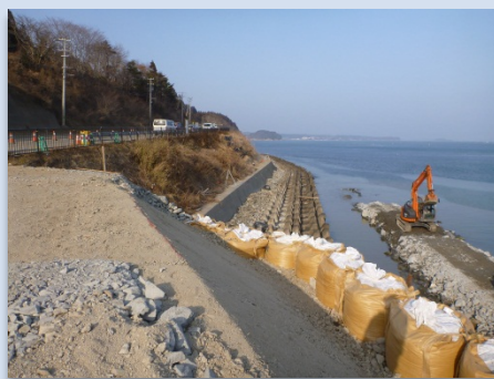
【仮設道路工事状況②】
