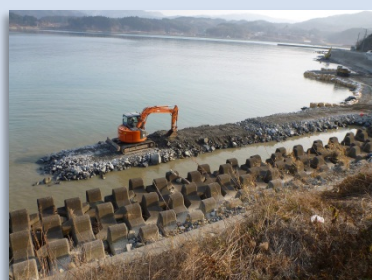
【仮設道路工事状況①】
