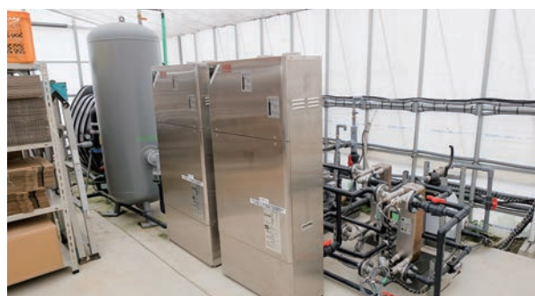
導入したヒートポンプシステム
