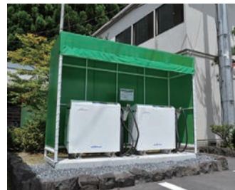
太陽光で発電した電気を V2H を通じて PHV に充電しています
