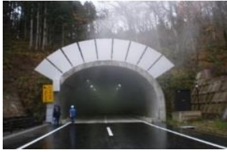
国道108号 荒雄湖トンネル (大崎市)
