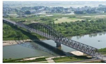
国道113号 丸森大橋 (丸森町)
