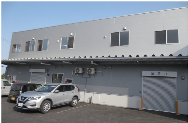
復旧した水産加工工場(気仙沼市)
