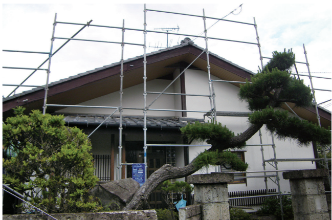
足場が組まれた住宅（名取市）
