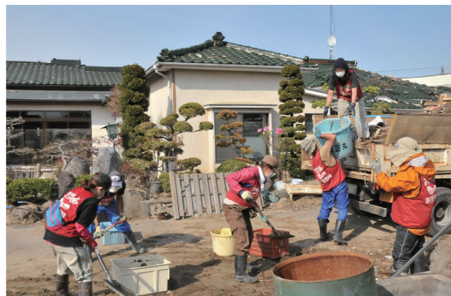
ボランティアによる泥出し作業（石巻市）
