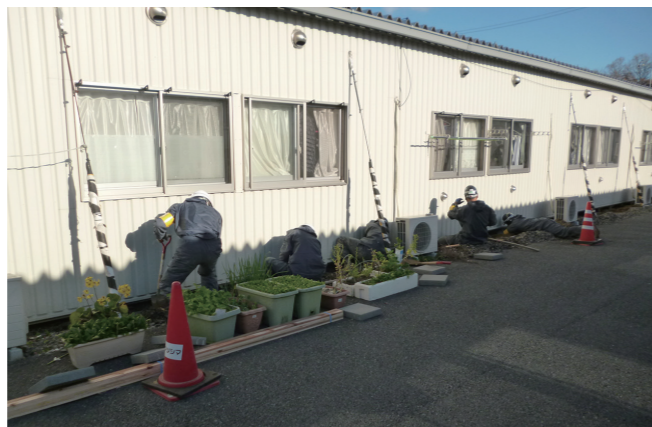
建設型応急住宅の補修工事
