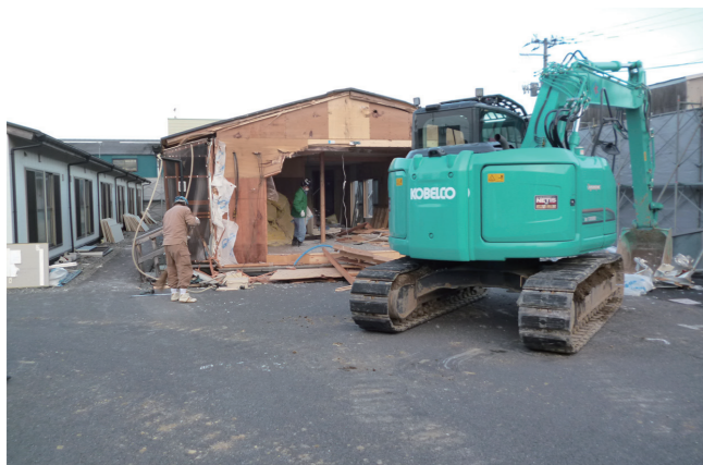
建設型応急住宅の解体
