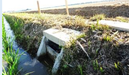
実際の落水工の写真
