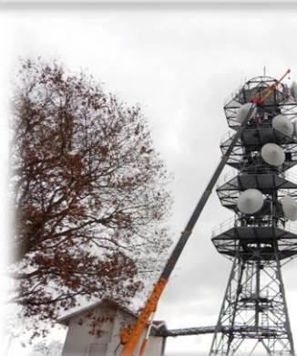
アンテナの施工状況 （小池ヶ平無線中継局）
