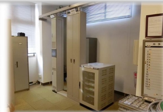
更新した無線設備 （麓山浄水場無線室）
