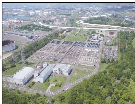
下水処理場 (浄化センター)
