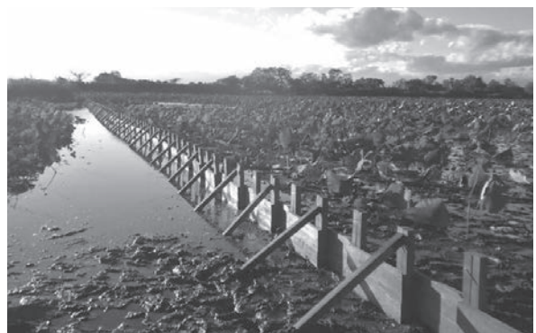
▲エコトーン造成作業の様子
