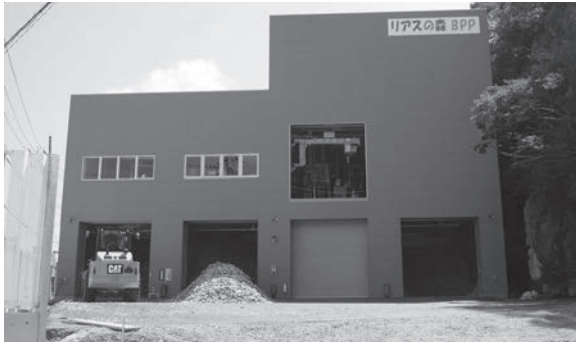
▲木質バイオマス熱電併給施設
