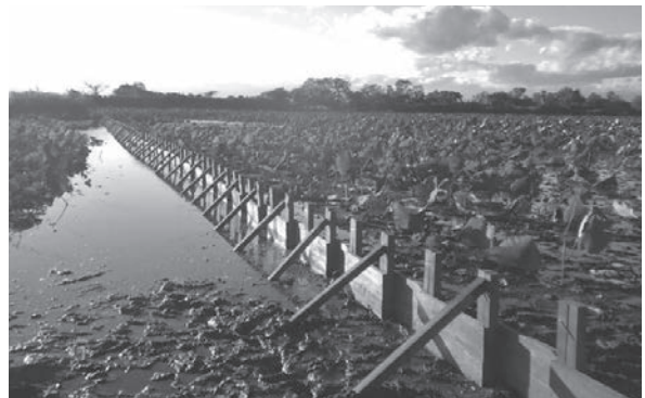
▲エコトーン造成作業の様子
