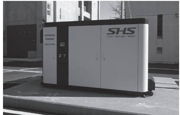
▲スマート水素ステーション
