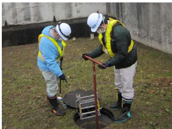
バルブ開閉作業確認
