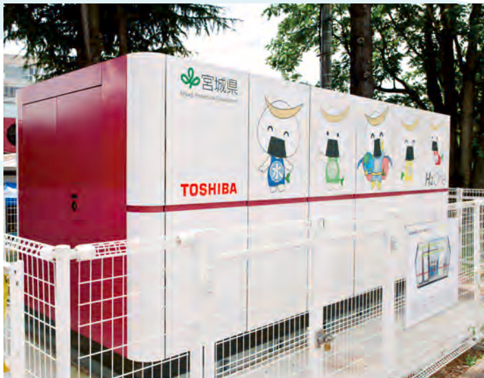
水素エネルギー発電設備(楽天生命パーク宮城)
