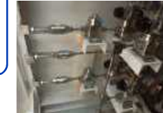
過流防止弁と緊急遮断弁
