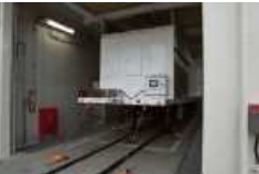
ステーションから散水受入のための開閉式屋根
