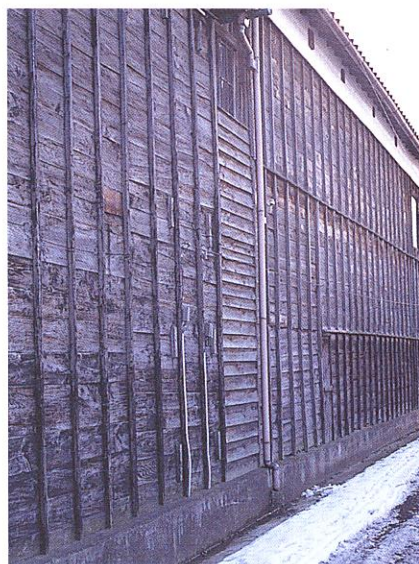
空地によって露出した町屋の側壁
