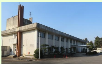
本館(事務室・実験室等)
