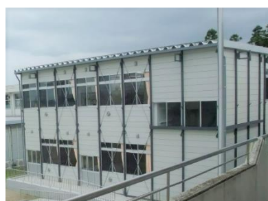
仮設校舎の増改築 (古川支援学校)
