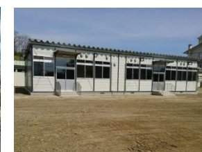
仮設校舎の設置 (小牛田高等学園実習棟)
