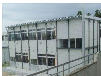
仮設校舎の増改築 (古川支援学校)
