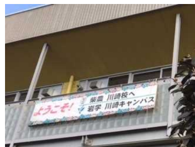
高等学校の余裕教室を活用し た分教室の設置 (岩沼高等学園川崎キャンパス)
