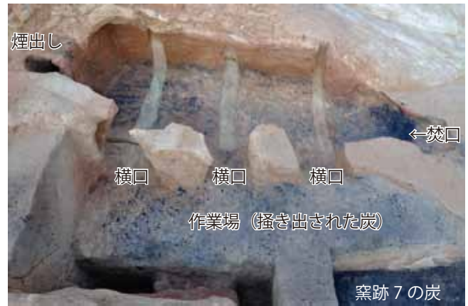
写真⑦ 炭窯跡 6 (南から) 炭窯跡 7 が崩れた後のくぼ地を作業場として、 その脇に造られました。
