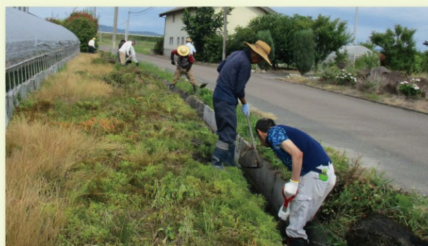
吉田地区資源保全隊広域協定運営委員会（亘理町） 水路の泥上げ
