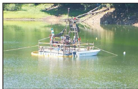
嘉太神ダムにおける実施設計のためのボーリング調査
