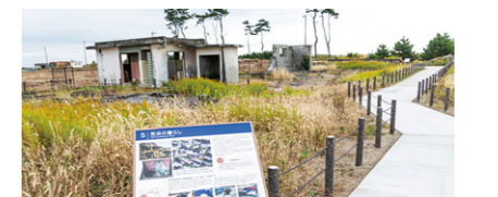
写真:住宅基礎・案内板(仙台市)
