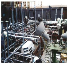
【 船内配管工事 】
