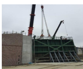
【水門ゲート据付現場】
