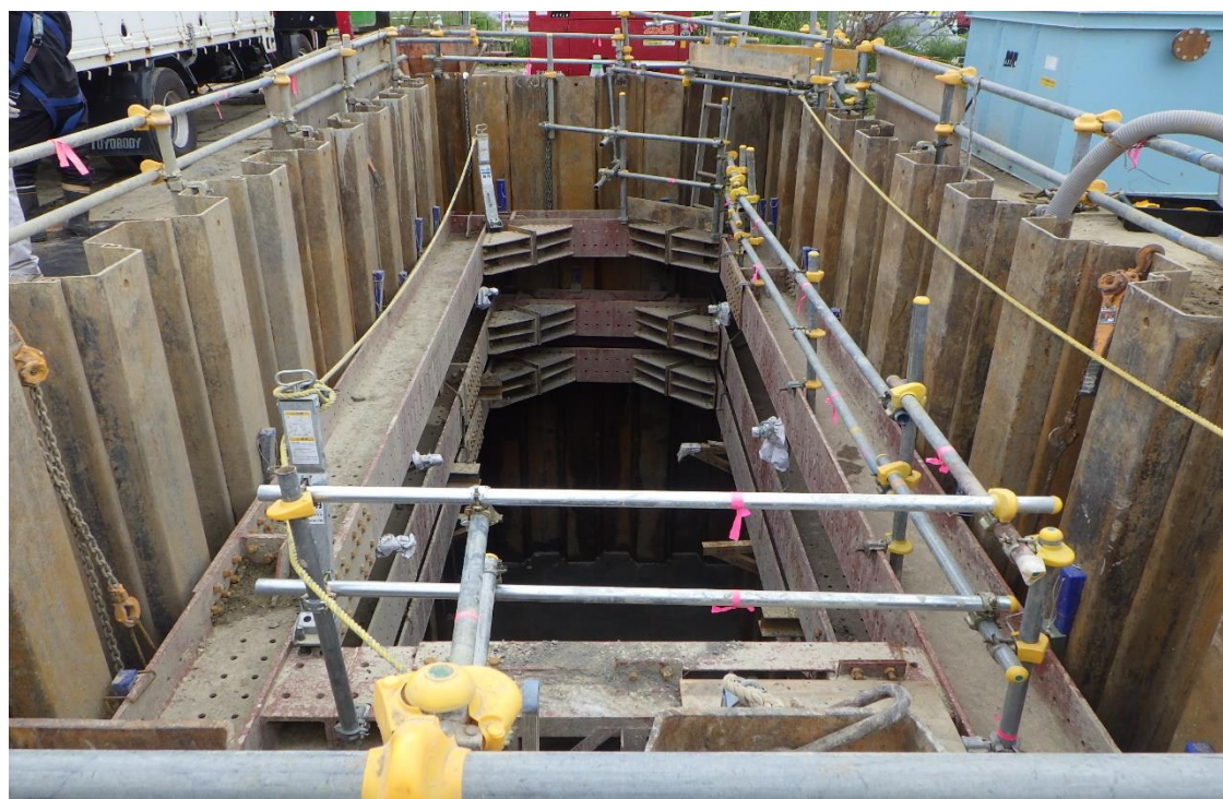
発進側立坑の施工状況
