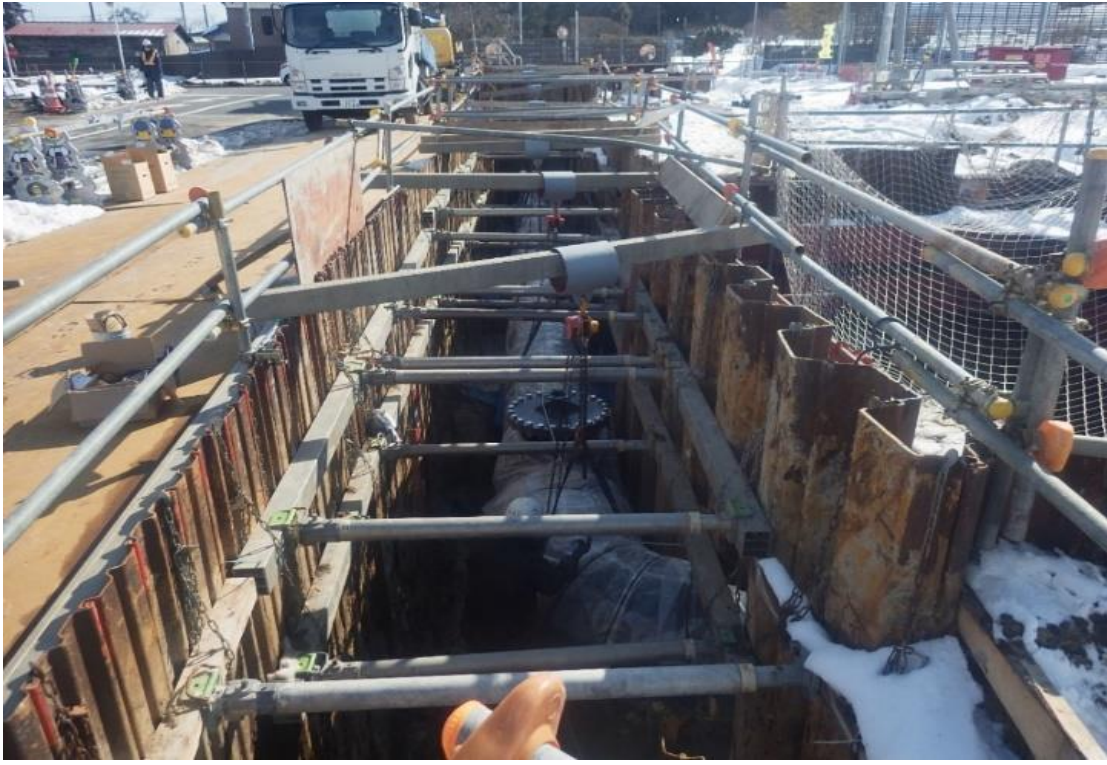
工業用水道管の布設状況
