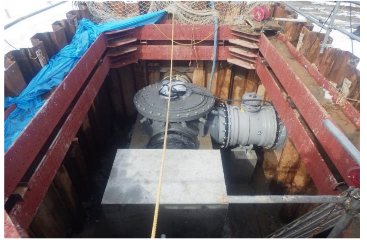
不断水分岐工の状況
