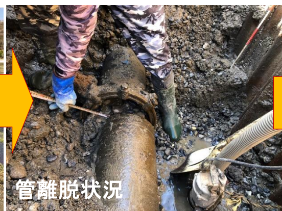
松山枝線(大崎市松山)の管離脱による漏水箇所
