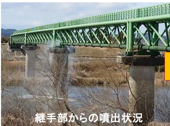
船越水管橋(大崎市鹿島台)継手部の漏水状況
