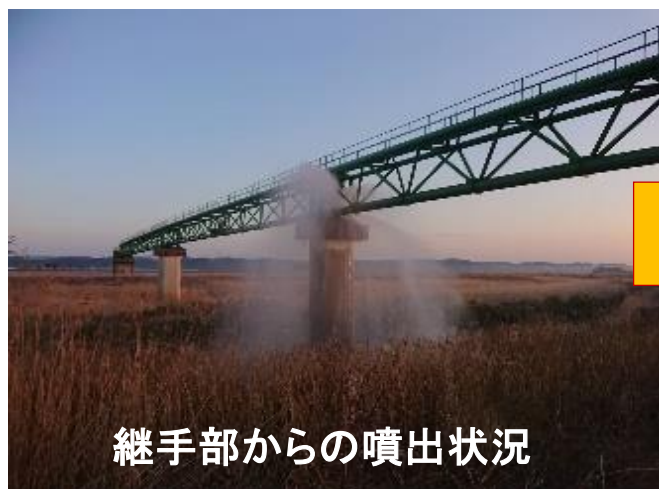
西川水管橋(大和町)継手部の漏水箇所
