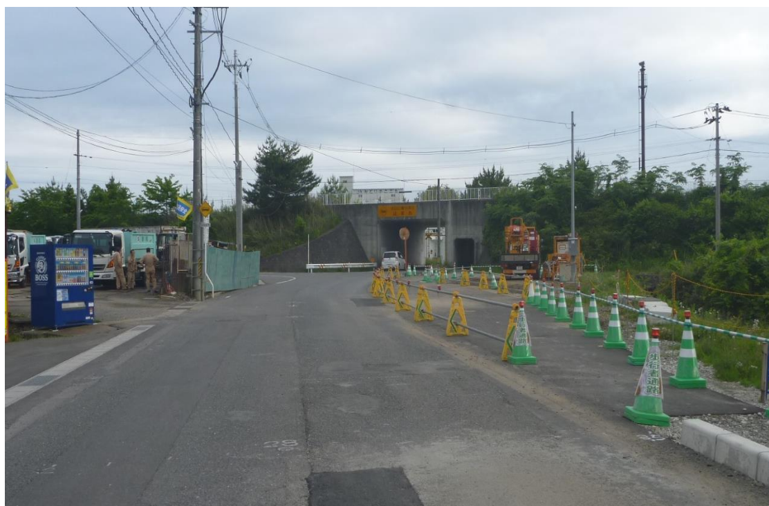
到達側立坑付近の仮設道路整備状況
