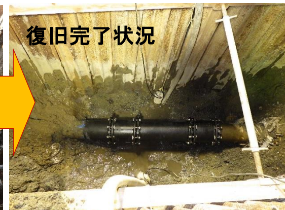
松山枝線(大崎市松山)の管離脱による漏水箇所
