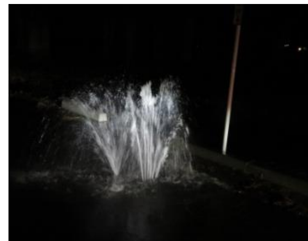
大崎市三本木YKK付近 空気弁漏水状況
