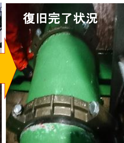
西川水管橋(大和町)継手部の漏水箇所
