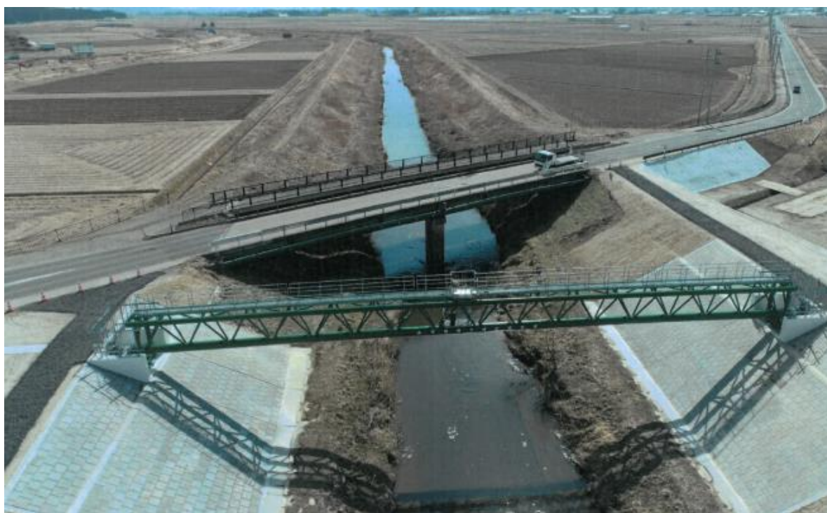
水管橋本体の完成状況
