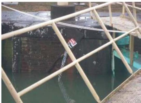
写真6.4.9 剥がれた量水標と変形した
