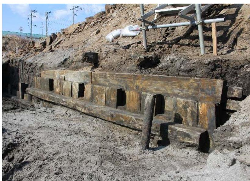
写真6.4.16 明治期の閘尾部翼壁(閘室側)の一部の遺構
