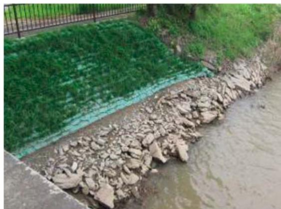
写真6.4.10 取り付け部法面の崩落
