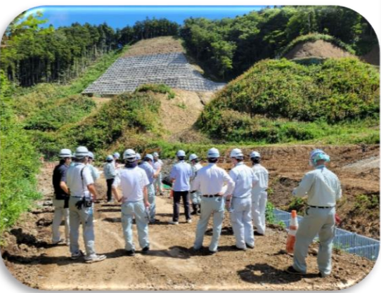
「第1回ダム建設事業研修」の状況①
