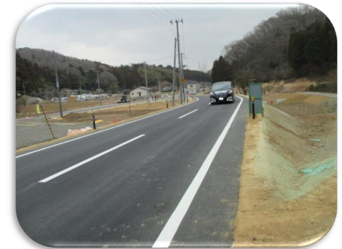
道路切替後の状況②
