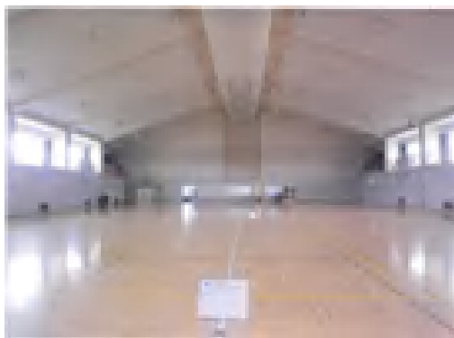
講堂天井改修（着手前）
