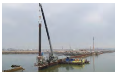
■施工中 L1堤防区間 鋼管矢板打込状況
