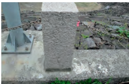
荒砥沢ダム防護柵復旧
