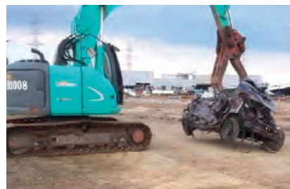
被災車両仮置状況
