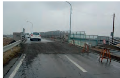
化粧坂橋 応急対応状況
