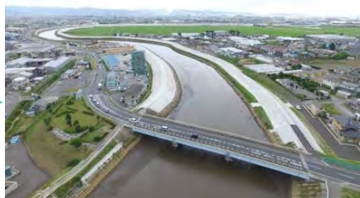
■完成 L1堤防区間 定川橋(国道45号)付近から下流を望む
