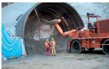
■ 施工中(トンネル抗口吹付工)
