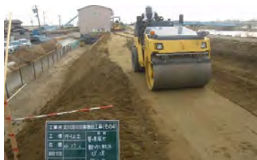
■施工中 沈下戻し区間流部 堤防盛土状況
