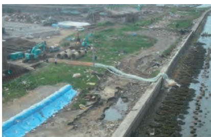
東部浄化センター 放流管応急復旧
