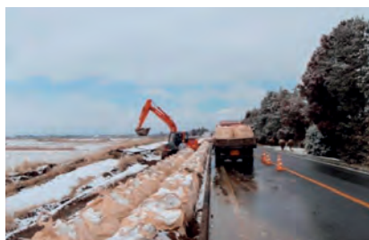
迫川堤防 応急対応状況
