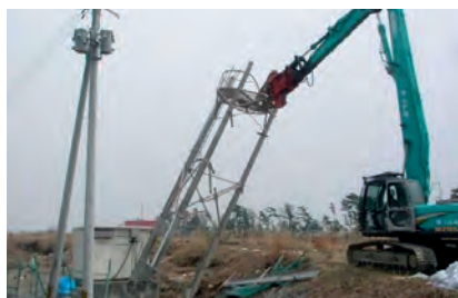
寺野警報局 応急対応状況
