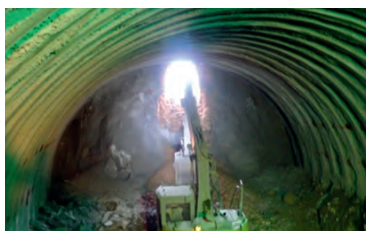
■ 施工中(トンネル貫通の瞬間)
