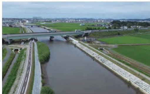
■完成 沈下戻し区間 三陸自動車道上流から下流を望む
