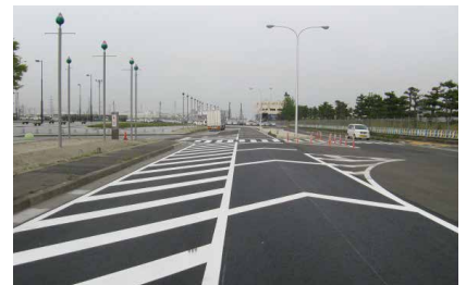
▲ふ頭5号線路工事了 (7/19最初の完了箇所)
