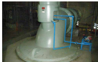
▲5号ポンプ復旧完了
