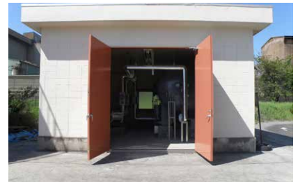
▲給水タンク復旧
