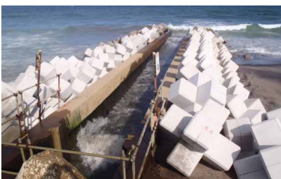
▲放流渠復旧状況
