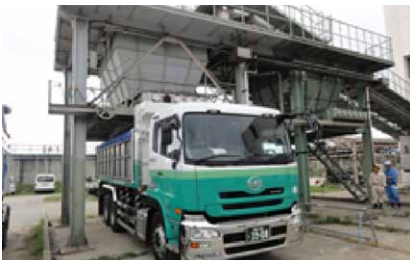
▲脱水ケーキ搬出状況
