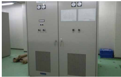
▲低圧盤設置状況(新棟)
