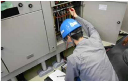
▲汚泥処理試運転状況
