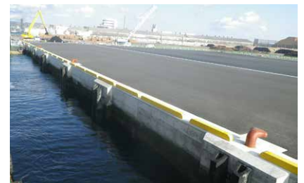
▲南浜岸壁復旧後
