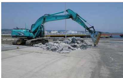
▲貞山2号岸壁エプロン取り壊し
