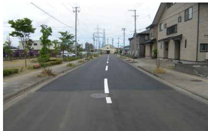
▲住宅地区の道路復旧後
