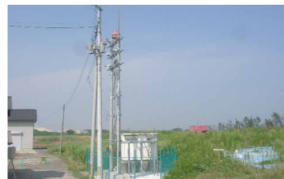
▲寺野警報所 復旧完了 サイレン塔は2柱式
