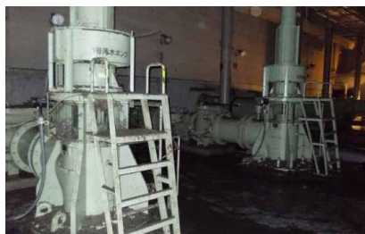
▲補機類の浸水により機能停止
