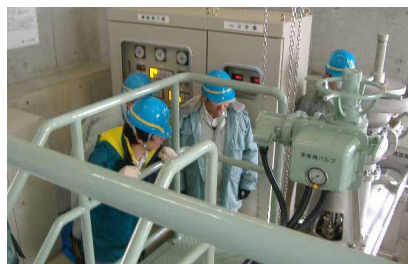
▲花山ダム管理演習状況
