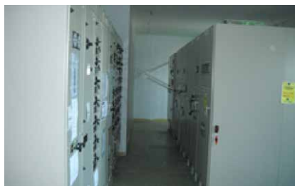
▲機器設置完了
