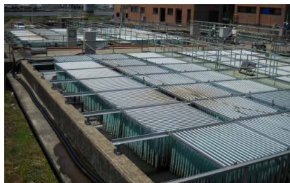
▲水処理施設の簡易生物処理(全景)
