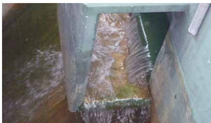
▲最初沈殿池通水開始状況
