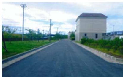
▲石巻浄化センター復旧後
