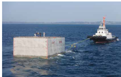
▲湾口防波堤災害復旧工事
