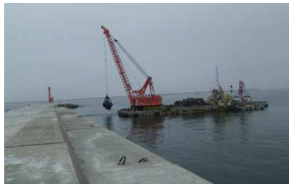
▲新北防波堤被覆石撤去
