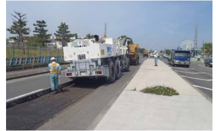
▲ふ頭5号線路面切削状況
