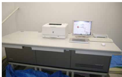
▲監視装置設置完了
