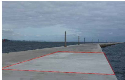
▲前南防波堤 工事完了
