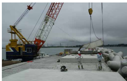
▲新北防波堤上部コンクリート打設
