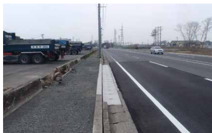
▲釜北線(その2)工事復旧後
