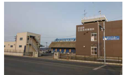
▲事務所復旧後
