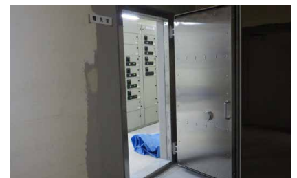
▲復旧状況(石巻第6ポンプ場:防水扉の設置)
