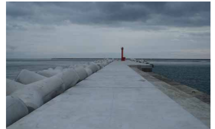
▲新北防波堤復旧完了
