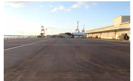
▲高松ふ頭舗装完了
