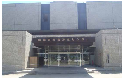
▲1階正面玄関状況
