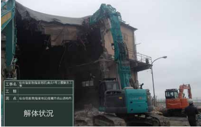
▲既存上屋の解体
