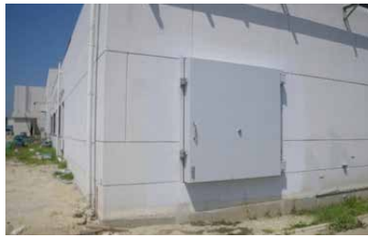
▲設備の搬入口については耐水扉を設置し復旧
