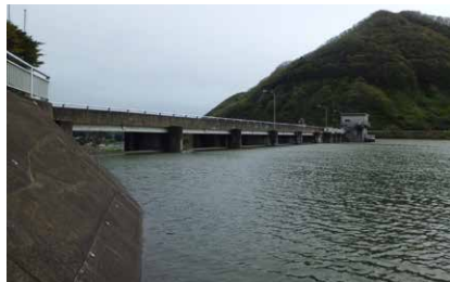
▲南川ダム湖面状況
