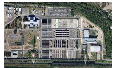
▲4系列 H24.9月 本復旧完了
