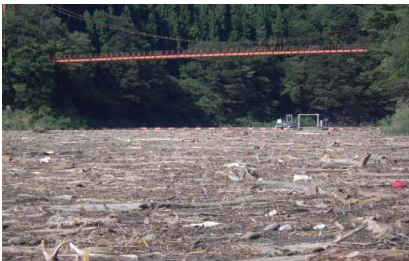
▲花山ダム流木状況
