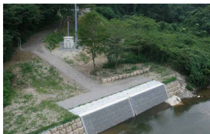
▲白沢河川水位観測所 復旧完了 新たに約40m上流右岸に設置
