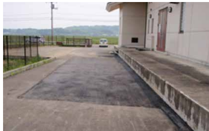
▲若柳第1ポンプ場復旧後
