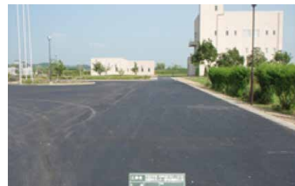
▲石越浄化センター復旧後
