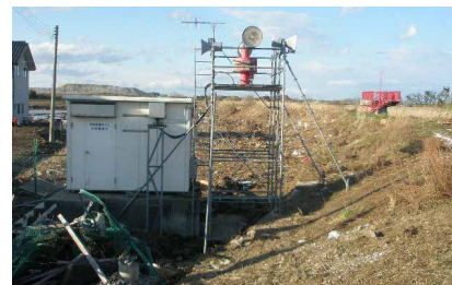
▲寺野警報所 復旧前 仮設の檣にサイレン、スピーカ等を設置
