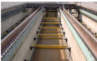
▲「最初沈殿池」復旧状況
