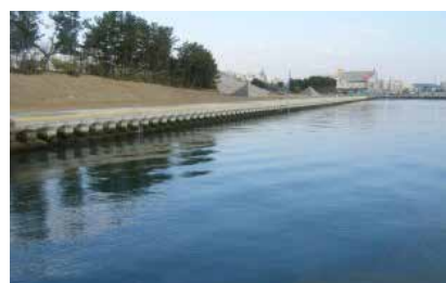
雷神護岸 復旧工事状況(仙台区)
