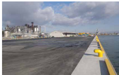
▲中島3号岸壁復旧後
