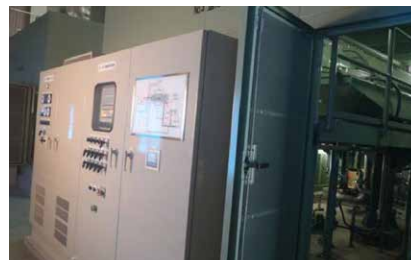
▲機械濃縮設備復旧完了
