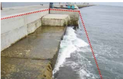
▲南防波堤 コンクリート打設前
