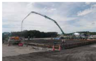
貞山ふ頭復旧工事状況(塩釜港区)
