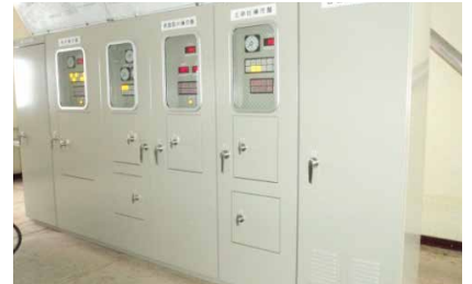
▲機側盤の更新工事完成
