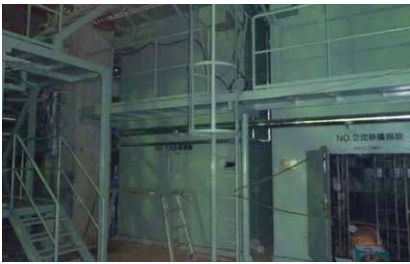
▲沈砂池設備沈砂掻揚機復旧状況
