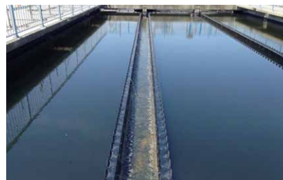
▲第4系列最終沈殿池復旧・処理状況
