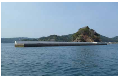
▲表浜防波堤復旧後
