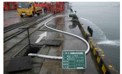
▲給水管の洗浄状況
