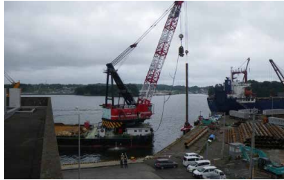
▲貞山2号岸壁鋼管矢板打設
