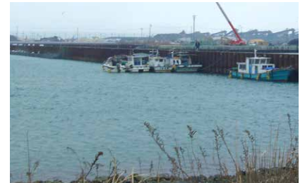
▲雲雀野廃棄物埋立護岸(一次締切完了)
