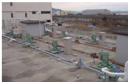
▲復旧状況(3系反応タンク機械設備)
