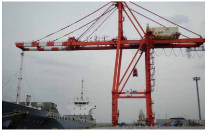
▲ガントリークレーン3号機復旧後
