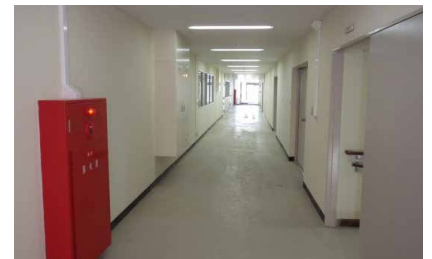
▲復旧状況(電気:照明設備, 消防設備)
