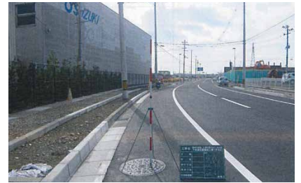
▲工業地区の下水道復旧後
