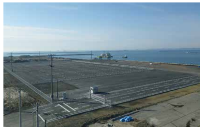
▲雲雀野中央埠頭荷捌地災害復旧工事復旧後
