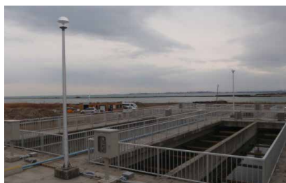
▲復旧状況(3系最終沈殿池)
