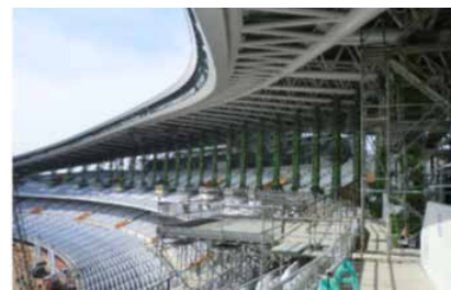
▲仮設柱の施工状況
