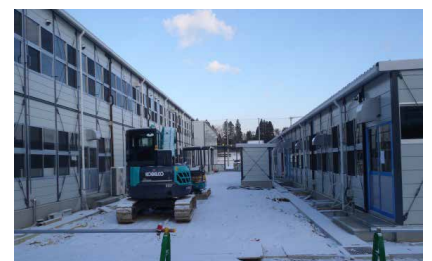
▲総合実習棟・機械実習棟・体育館
