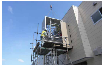
▲機械室棟2階に搬入する受変電設備
