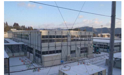
▲仮設実習棟全景
