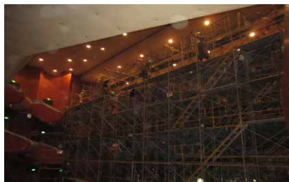
▲客席ホール足場架設
