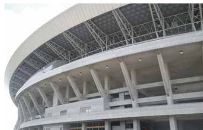
▲宮城スタジアムの復旧状況
