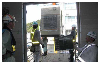
▲機械室棟2階に搬入する非常用発電機
