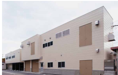
▲機械室棟(新築)
