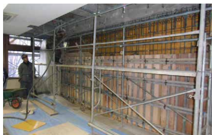
▲耐力壁工事中
