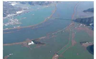
国道398号の新北上大橋（橋長565.29m・幅員8.0m）の上部工2径間が津波により落橋。早期に一般車両や工事車両の通行を確保しなければならないことから仮橋を施工しました。
