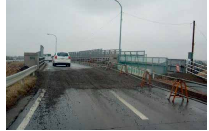
化粧坂橋 応急対応状況
