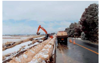
迫川堤防 応急対応状況
