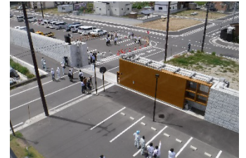
●2020.6 水門陸開閉鎖システム 運用開始
