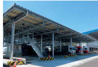
●2020.5 高砂コンテナターミナル 新トラックゲート
