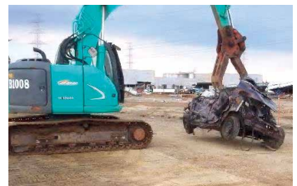
被災車両仮置状況
