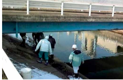
災害査定状況
