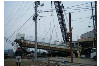
がれきの山を取り除く作業(国道398号 女川町)
