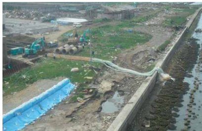
東部浄化センター 放流管応急復旧
