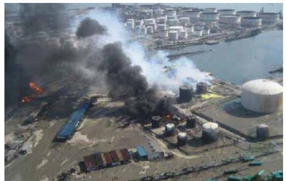
製油所の火災(仙台製油所)
