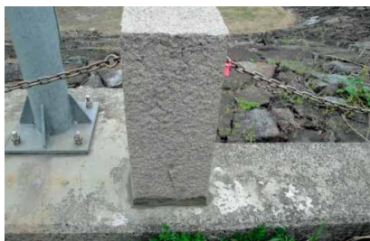
荒砥沢ダム防護柵復旧
