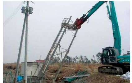
寺野警報局 応急対応状況
