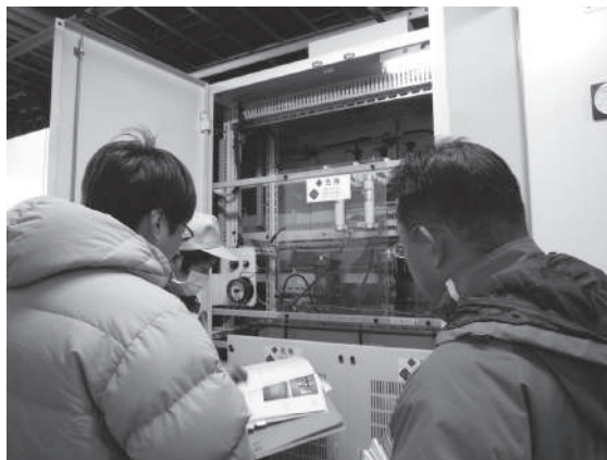
写真 災害査定の様子
