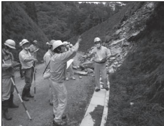
写真 林道被害の現地での確認状況
