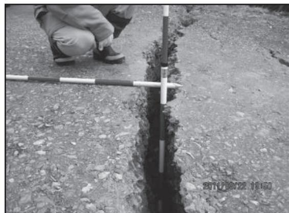
写真 林道施設の被災状況 3 [深刻なクラックの発生]
