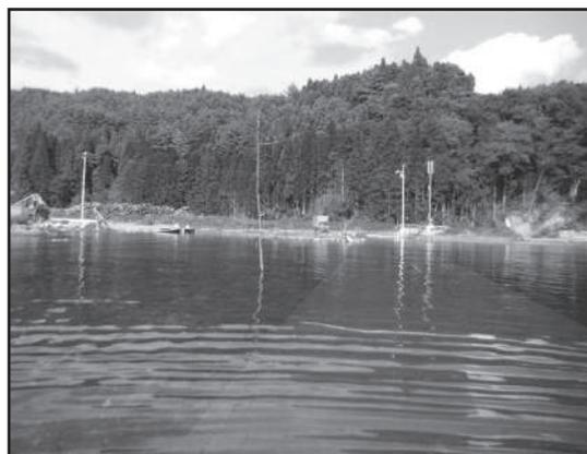
写真 林道施設の被災状況 4 [海岸沈降による路線の海没]
