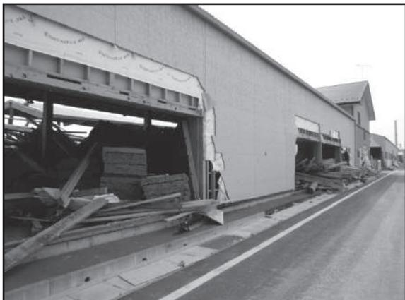
写真 製材工場の被災状況〔施設損壊，製材品流出〕
