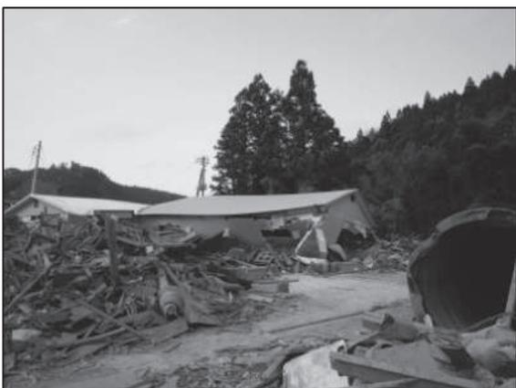
写真 特用林産物生産施設の被災状況〔施設建屋の倒壊〕
