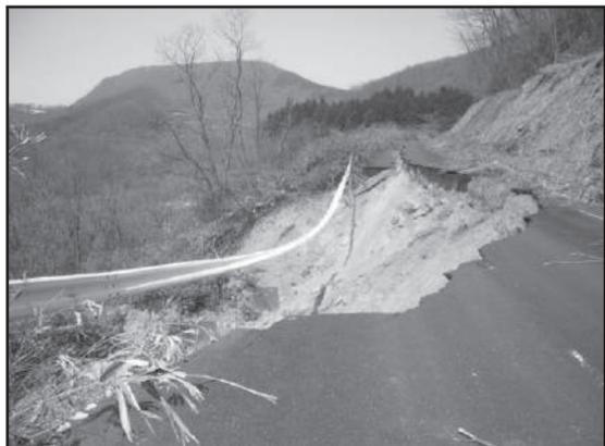
写真 林道施設の被災状況 1 [路体の流出]
