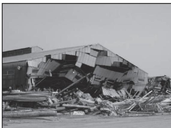
写真 合板工場の被災状況〔建屋の倒壊〕
