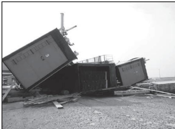
写真 製材工場の被災状況〔木材乾燥施設全壊〕
