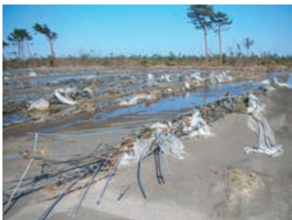
津波により損壊したパイプハウスと流失した農作物（名取市北釜地区）
