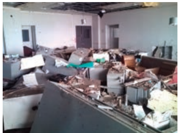
1階事務室の状況
