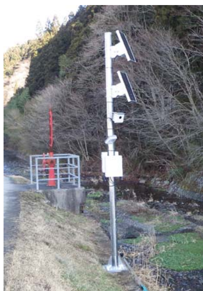
監視カメラ 設置状況(折立川)
