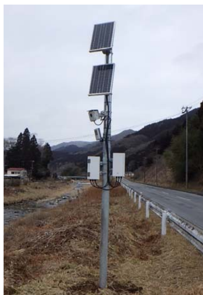
監視カメラ設置状況(津谷川)
