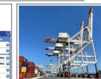
インバータ制御方式のガントリークレーンの導入(全6基)
