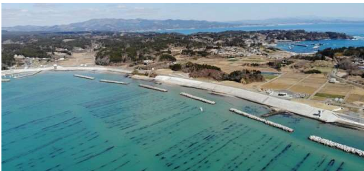
図 4-12 長須賀海岸 堤防完成状況 11
