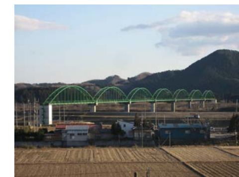
＜ 阿武隈川水管橋 ＞
