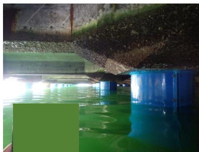
補修完了 (杭被覆防食工) 貞山4号栈橋
