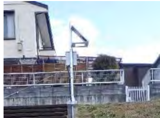
危機管理型水位計 (荒川・村田町)
