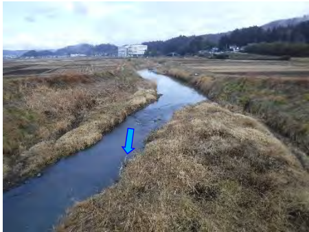
掘削前（①箇所）
