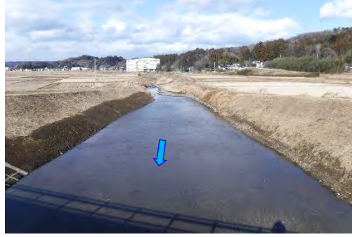
掘削後（①箇所）
