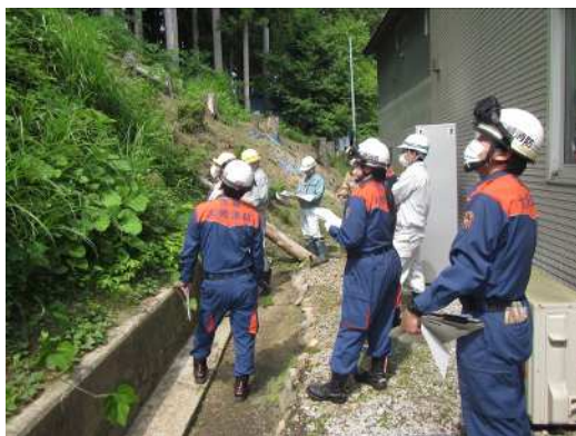
【色麻町内の点検状況】
