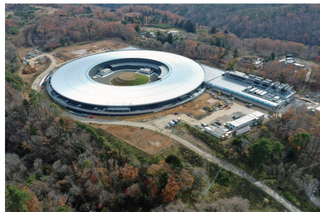
建設中の次世代放射光施設 （出典：（一財）光科学イノベーションセンター）
