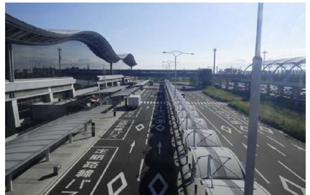
2011(平成 23)年 9 月 25 日に復旧した仙台空港ターミナルビル
