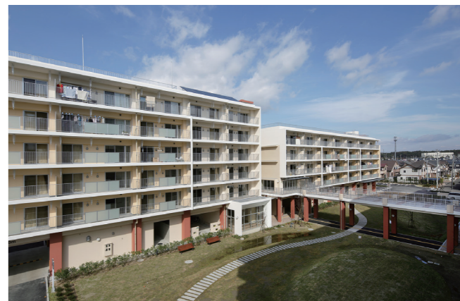
多賀城市桜木住宅
